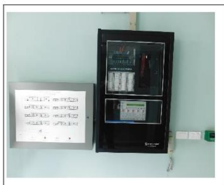
ตู้ควบคุมระบบแจ้งเหตุเพลิงไหม้
